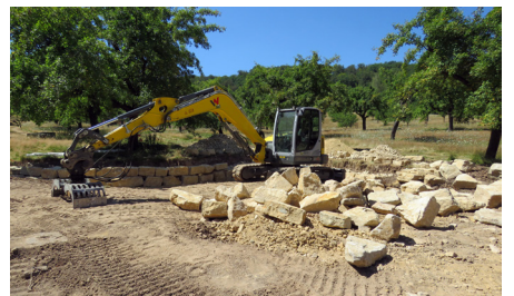
▲ Constructioun vun enger Dréchenmauer.
