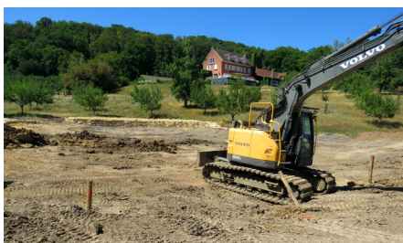
▲ Bagger-Aarbechten un den neien Weieren um Kléngelbuer.
